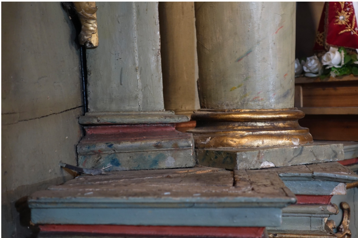
Fot.11 i 12. Sławęcın, kościół p.w. św. Katarzyny, ołtarz boczny lewy. Stan przed konserwacją. Widoczne m.in. spękane, odspojone i wybrzuszone warstwy na mensie ołtarza, a także ubytki warstw.
