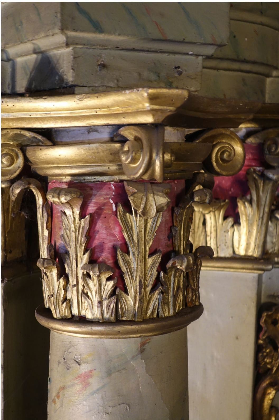
Fot.9. Sławęcín, kościół p.w. św. Katarzyny, ołtarz boczny lewy. Stan przed konserwacją. Widoczne m.in. spękania i wybrzuszenia zapraw wraz późniejszymi warstwami na trzonie i kapitelu kolumny oraz otwory po drewnojadach.
